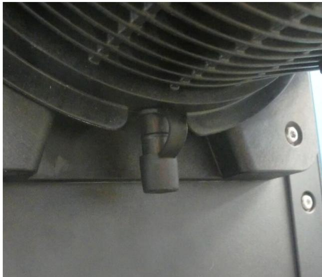
Durante la instalación, quite la tapa de goma de la abertura para dar lugar a la tubería del rebose de seguridad conectada, pero sin retirar la tapa por completo.
